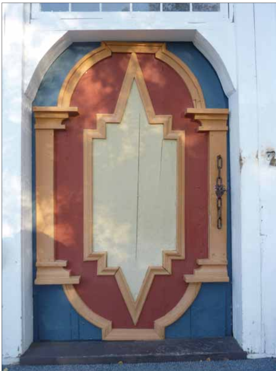
Figur 40. Den dekorativa ytterdörren kommer från Åseles gamla kyrka och är troligen från 1750, möjligen ännu äldre. Stilen är barock, på gränsen till renässans. Foto: Andreas Grahn/Länsstyrelsen.
